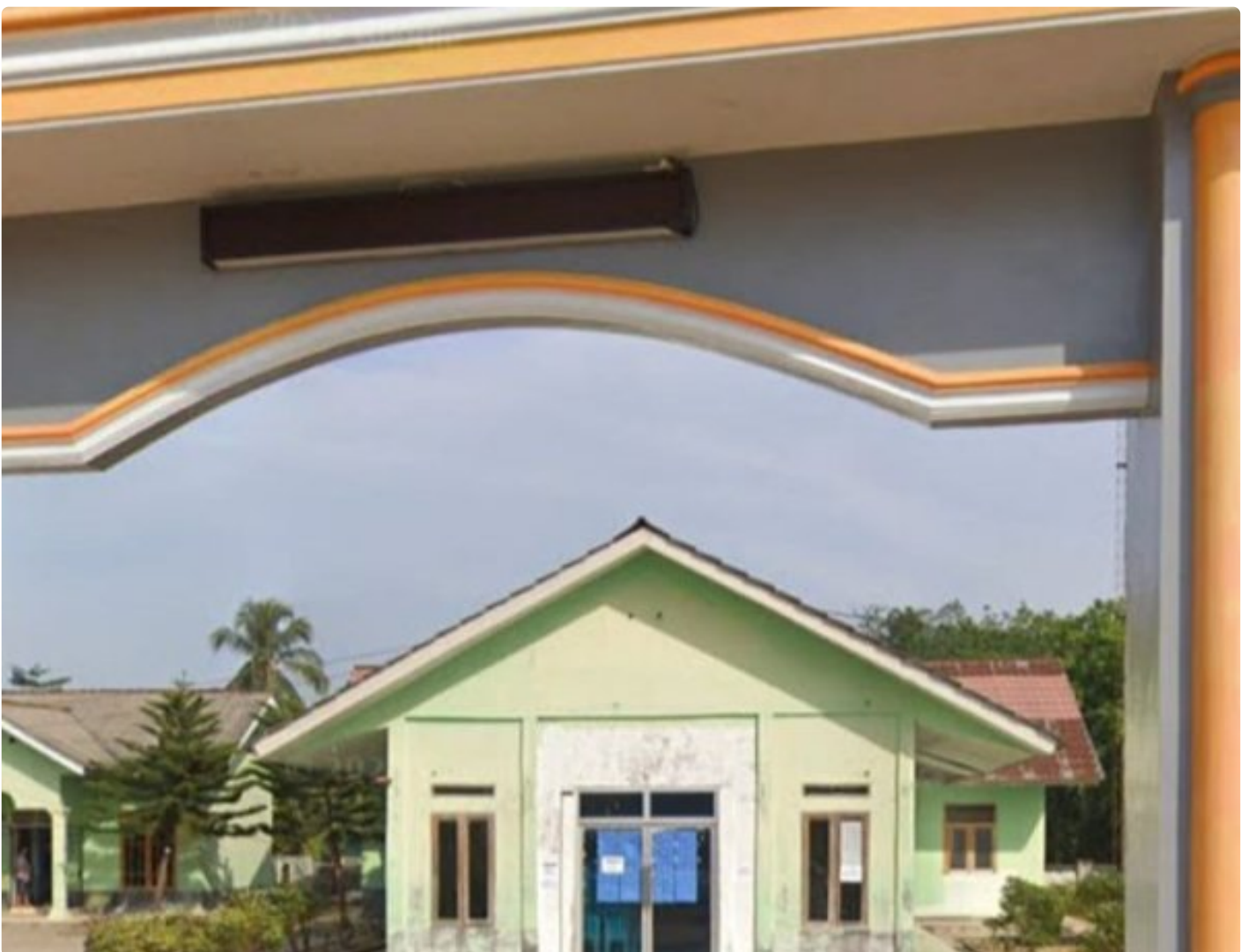
Balai desa Muara Tenang Tanjung Raya
